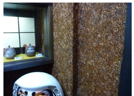
☆お茶の茎が混ぜられた壁。
